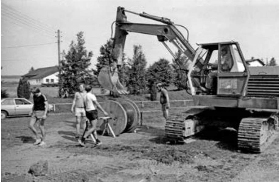
Aufbau der Flutlichtanlage am 21.08.1980
