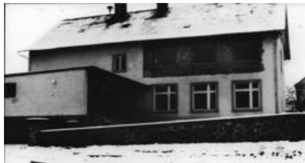
Aus der ehemals Lehrerdienstwohnung entsteht im Jahre 1966 der 4. Schulsaal. Im Vordergrund die Bruchsteinmauer.
