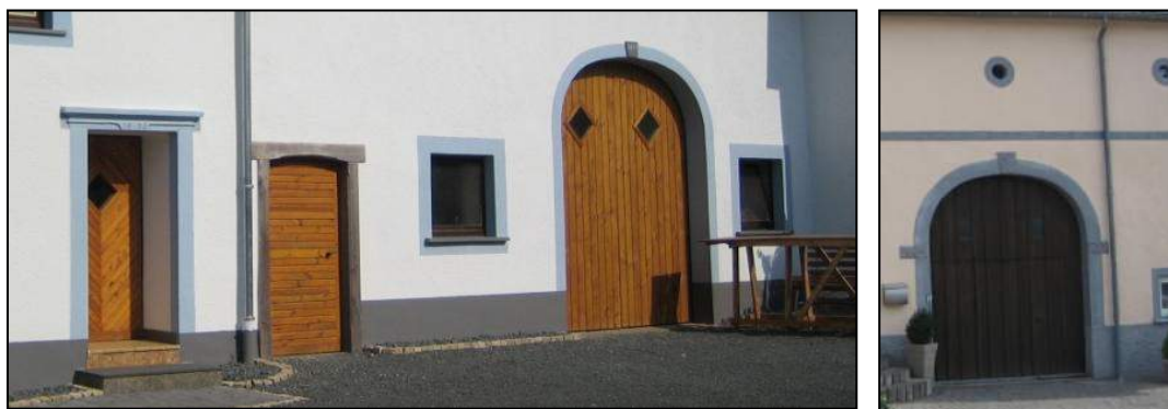
Abbildung: Türgewände und Scheunentorgewände mit Schlussstein Quelle: Eigene Fotografien
