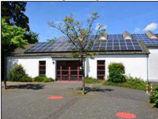
Abbildung: Turn- und Veranstaltungshalle (Grenderichhalle) Quelle: Eigene Fotografie
