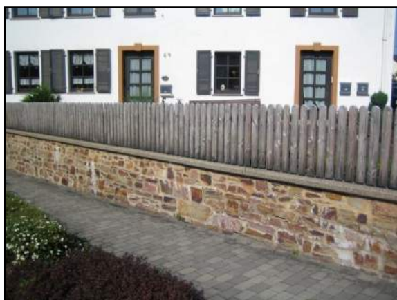
Abbildung: Grundstückseinfassung mit Mauer aus Sandstein und Staketenzaun / mit grüner Hecke Quelle: Eigene Fotografien
