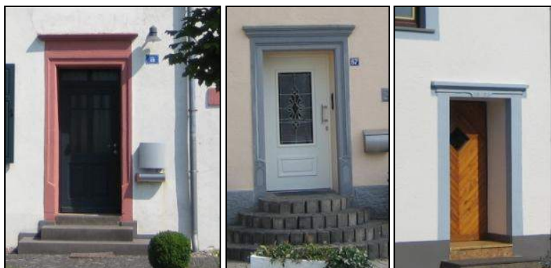
Abbildung: profilierte Türgewände und Türstürze Quelle: Eigene Fotografien
