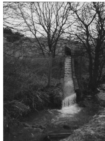
Die gereinigten Abwässer werden in den Engbach abgeleitet
