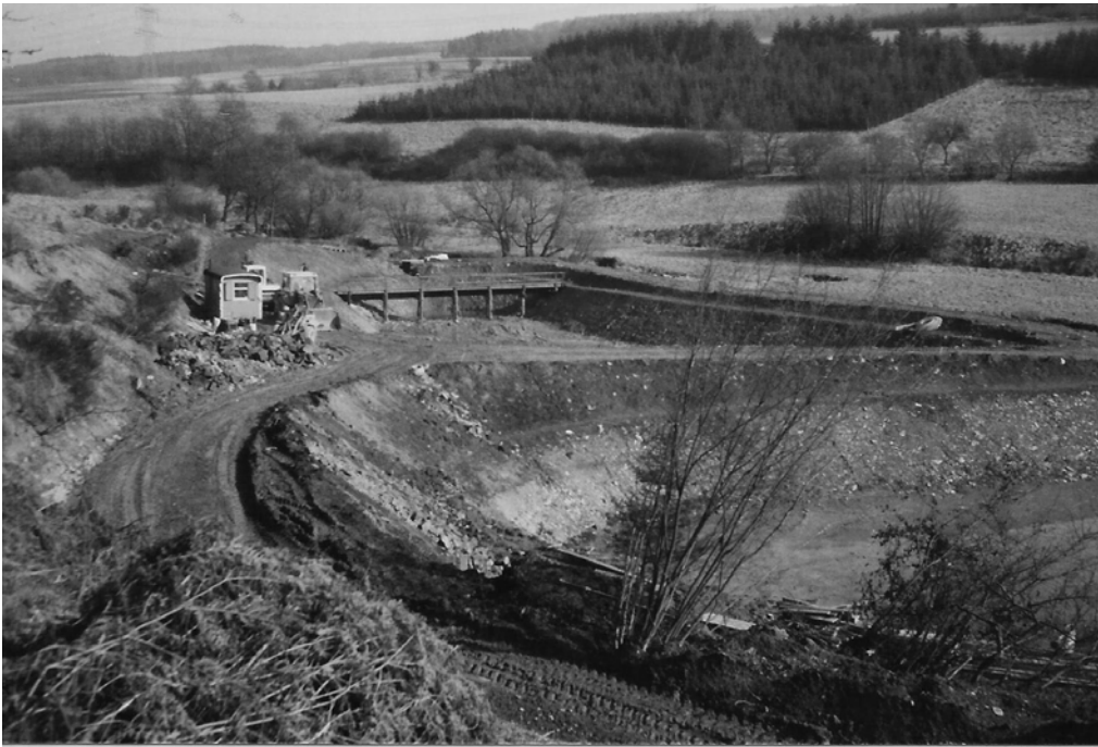
Die im Bau befindliche Kläranlage am 11.02.1989
