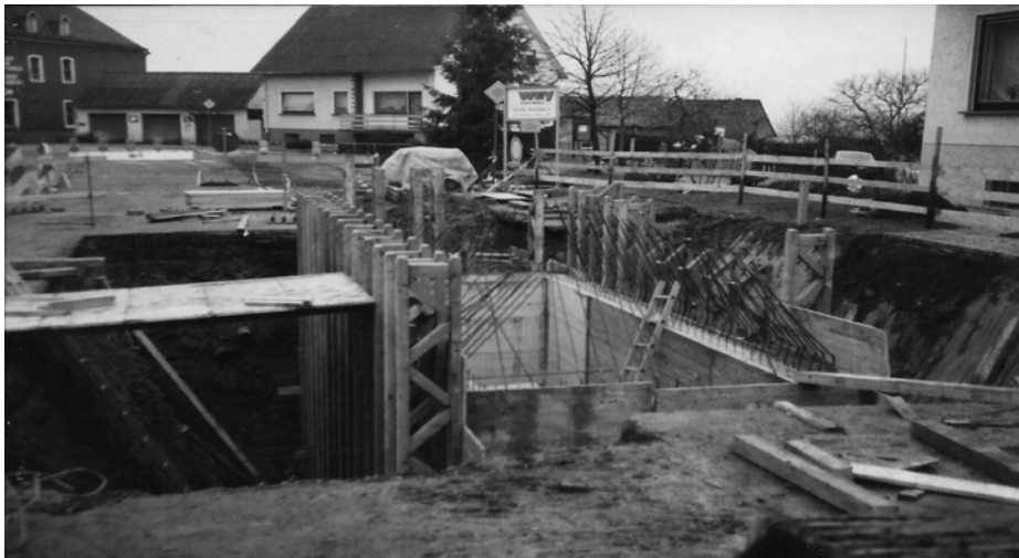
Regenüberlaufbecken in der Hauptstraße vom Dez.1986
