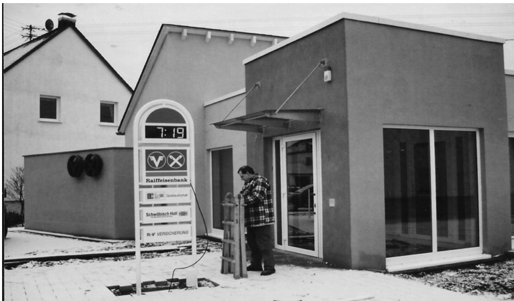
Vor dem großen Eröffnungstag werden noch Restarbeiten durchgeführt Aufnahme v. 14.01.2000
