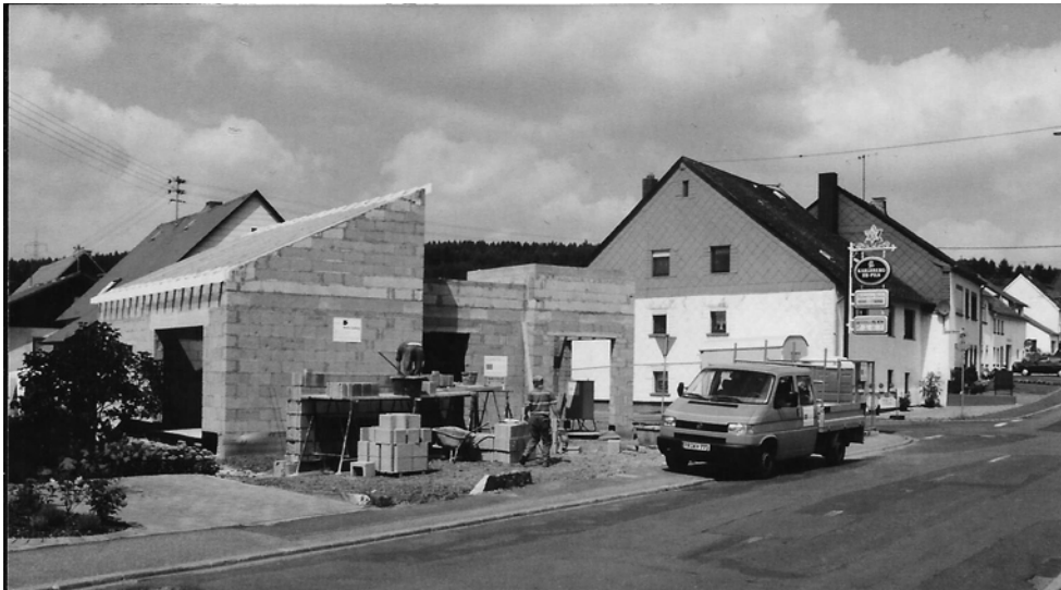
In der Hauptstraße entsteht ein neues Raiffeisengebäude (Aufnahme v. 13.08.1999)
